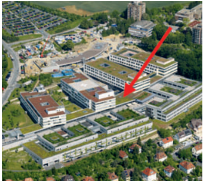
■ Abb. 1c: Luftbild des ZOM/ZIM Komplexes. Die Radiologie ist in der Mitte des Gebäudekomplexes (roter Pfeil) untergebracht. Im ZOM (die beiden Gebäude links des Pfeils) befindet sich die zentrale chirurgische Notaufnahme (CNA) mit dem Polytrauma-CT sowie die beiden feststehenden CT Geräte des Institutes. Im ZIM (die beiden Gebäude rechts des Pfeils) befinden sich die beiden 3T MRT's.
