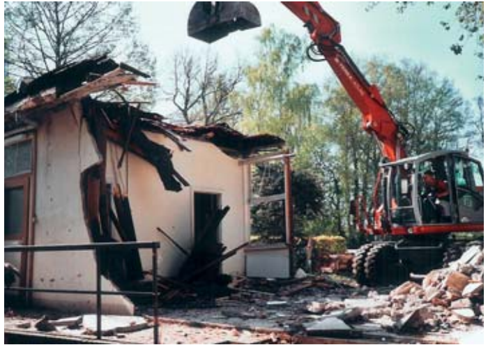
■ Abb. 3: Beim Abriss der Röntgenbaracke 2007 sieht man am besten das wahre Innenleben der Bausubstanz. Das Gebäude diente von 1973 bis 1985 als Röntgenabteilung, später als Archiv.
