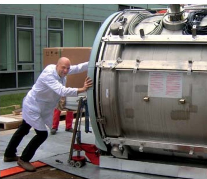
■ Abb. 2: Das 3.0 Tesla-MRT-Gerät wird in den Bau eingerollt (Prof.Dr. W.Hirsch). Mehr als eine Hand war für diesen Kraftakt notwendig, sowohl bei der Beschaffung als auch beim Einbringen des Gerätes
