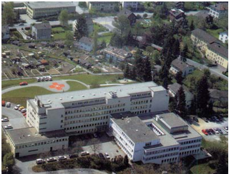
■ Abb.1: Das Ostschweizer Kinderspital in St. Gallen - Luftaufnahme
